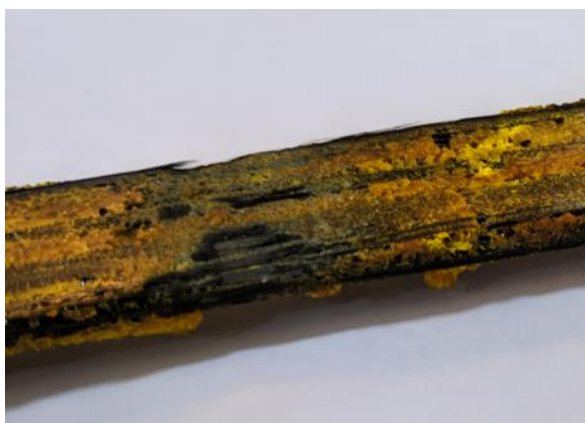
Σχήμα 6. Σημείο σε σύνθετο υλικό νεολάκης πριν την επισκευή
