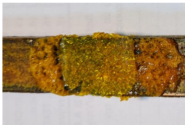
Σχήμα 7. Το ίδιο ακριβώς σημείο στο σύνθετο υλικό νεολάκης μετά την επισκευή
